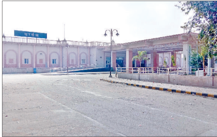
नारनौल। रेलवे स्टेशन का तैयार किया गया मुख्य भवन।
